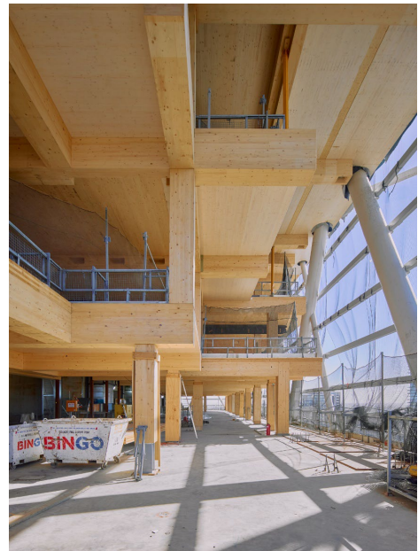
Kuva 44. Atlassian Central © SHoP Architects
