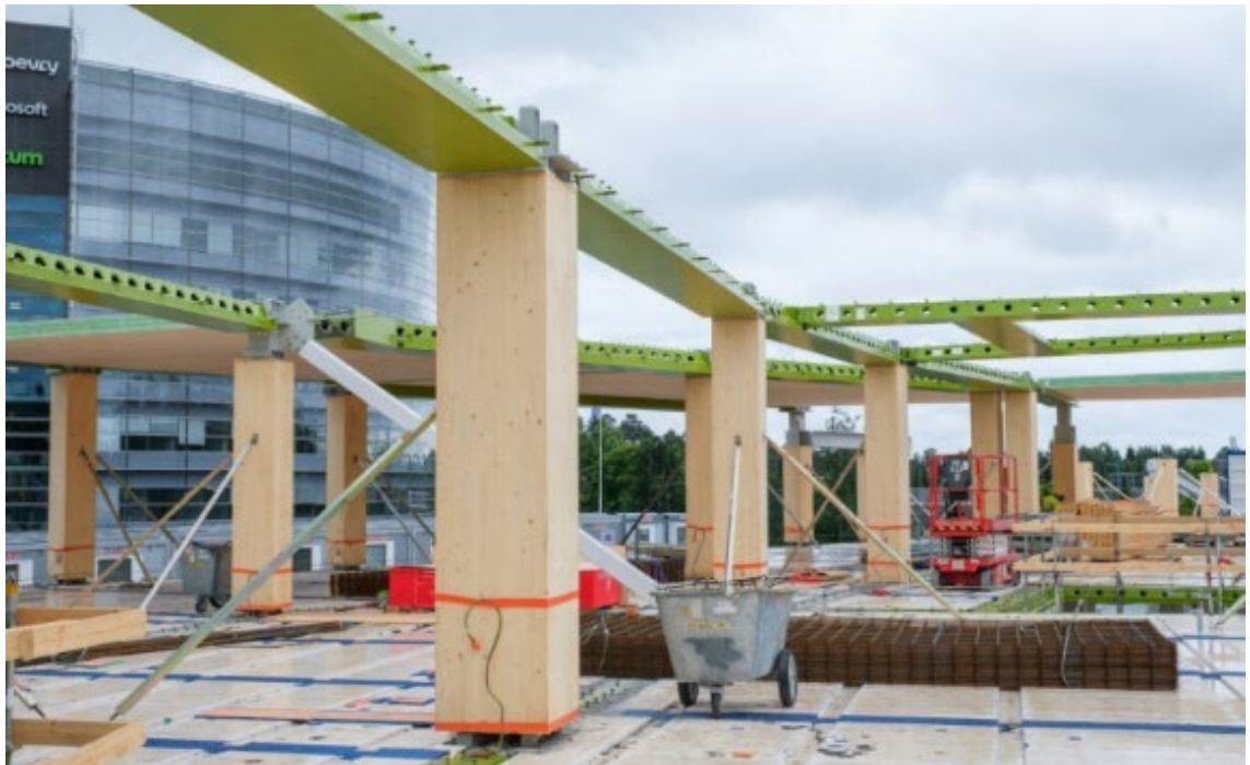
Kuva 21. Rakennuksen runko on toteutettu puu- ja teräsrakenteiden hybridinä (Teräsrakenneyhdistys 2025)
