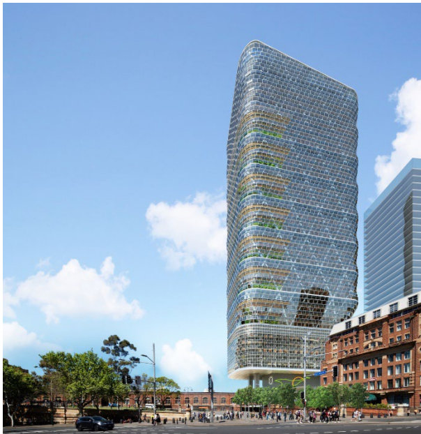
Kuva 43. Atlassian Central © SHoP Architects
