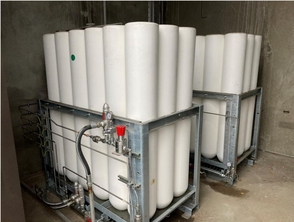
Kuva 4. Paineistetun biokaasun (CBG) säilytystä. J.Tiainen. 2022
