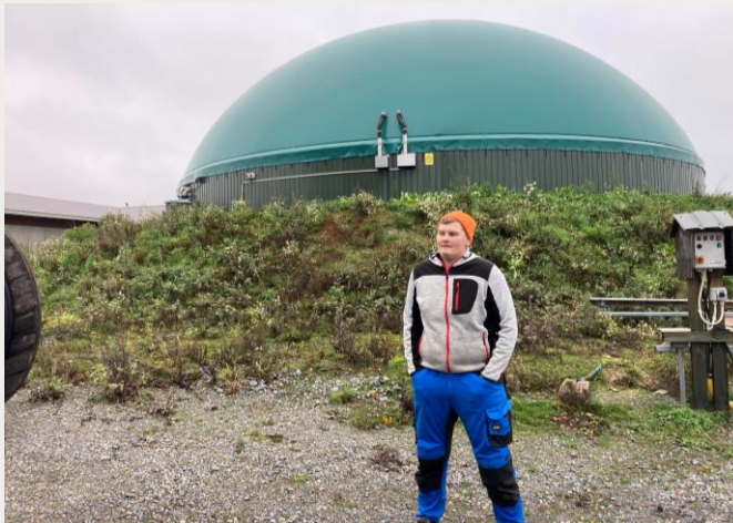
Kuva 3. Tyypillinen maatilan mädättämö ja sen kaasukupu. J.Tiainen. 2022
